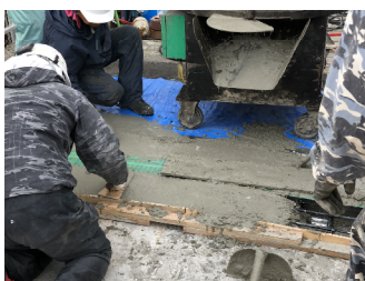
伸縮装置取換え工事の様子
