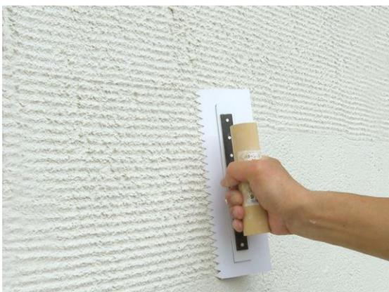
2) 模様出しは、専用くし目ゴテ(ぎざぎざくん)を使用し、横に引きずります。その際、コテは塗付面に対して45度程度ねかせて塗りますと、よりくっきりとした仕上がりになります。
